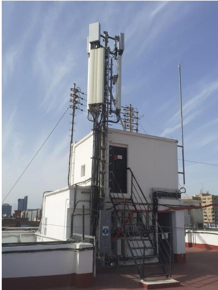
*Imagen 1: Mástil en azotea con escalera y sistema de seguridad*
